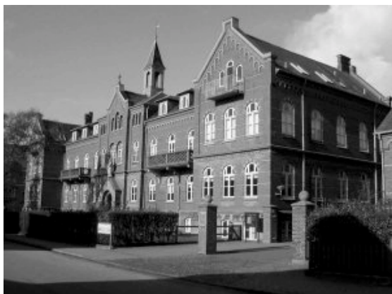
Den gamle hovedbygning, Sct. Josephs Hospital i Nørregade
